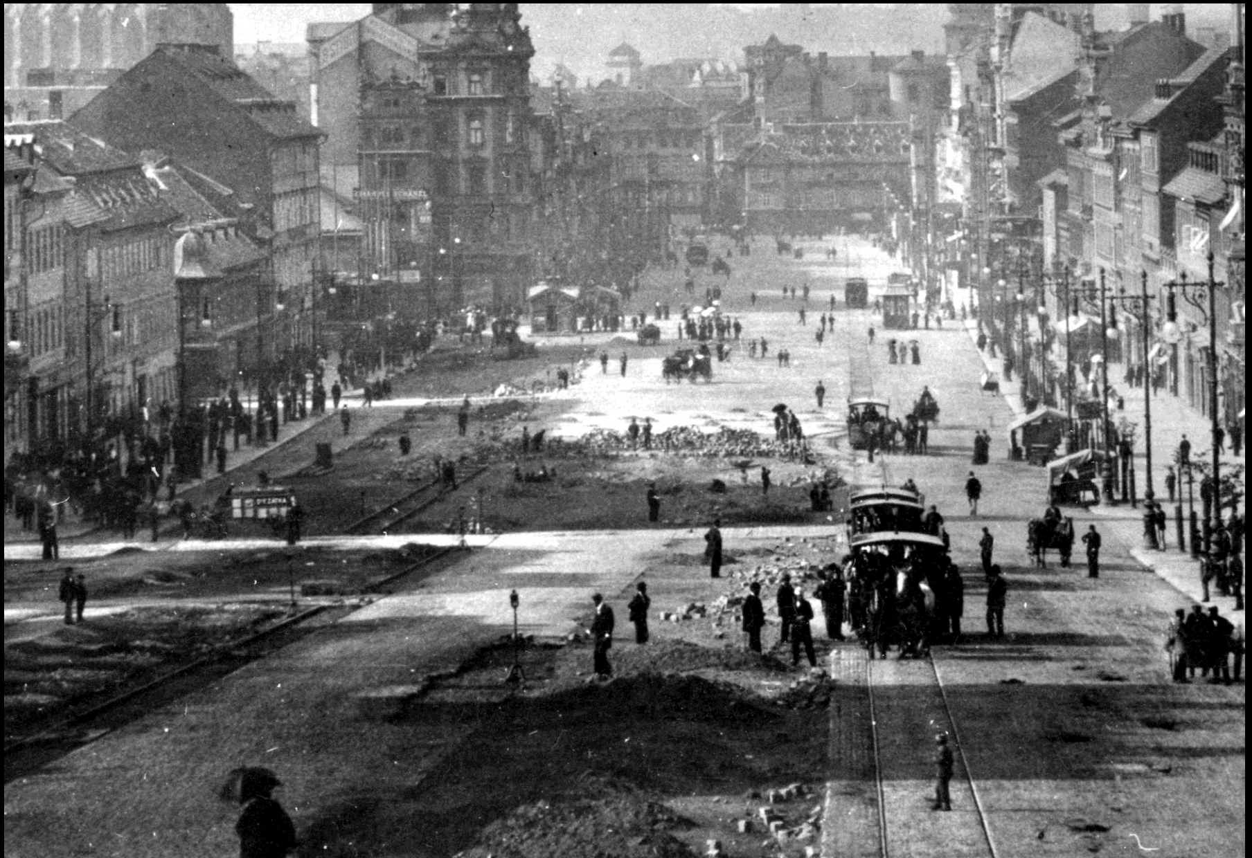
Rekonstrukce na Václavském náměstí v roce 1895
